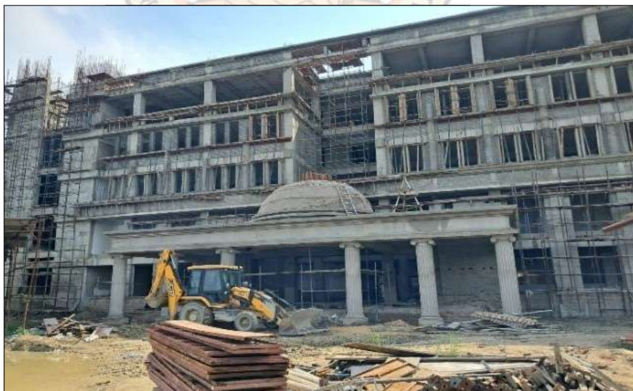
नया आगामी शैक्षणिक प्रशासनिक बिल्डिंग
